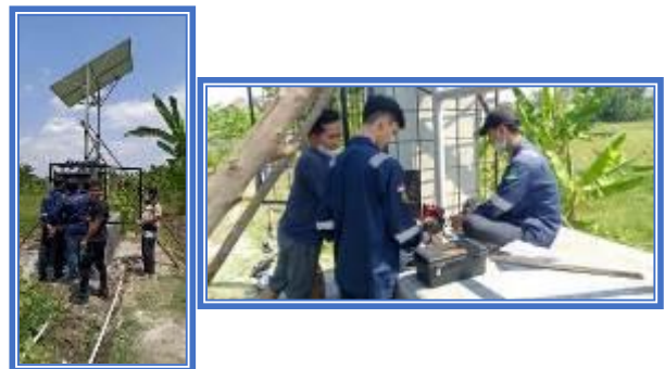
Gambar 10. Tahapan Perakitan Panel Surya
