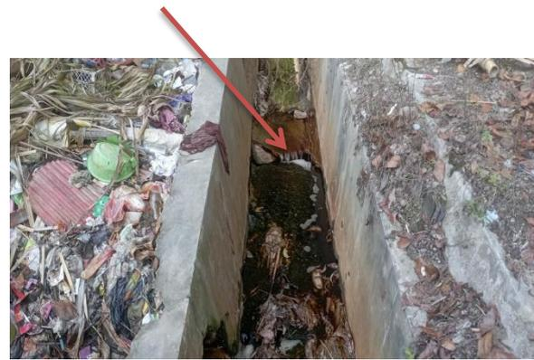
Gambar 5. Saluran Pembuangan limbah cair yang rusak
