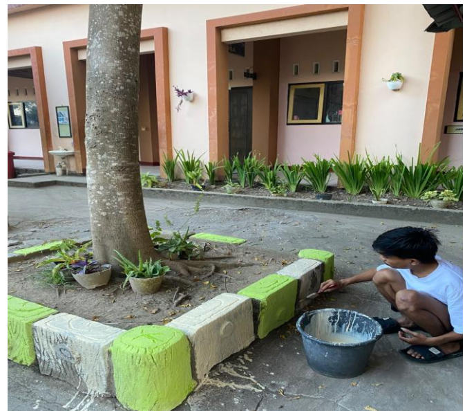
Gambar 3. Kondisi taman sekolah setelah dilakukan revitalisasi.
